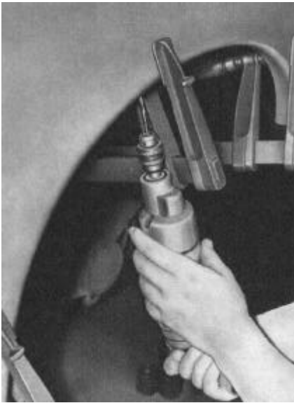
Bild K 16. Nietlöcher bohren
