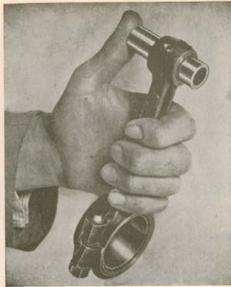
Fig. 1-49. Piston pin fit
